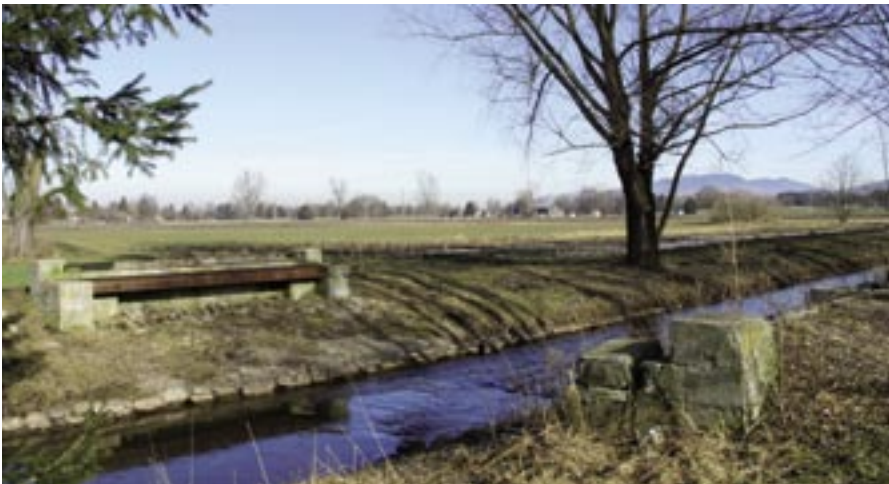
Die bestehenden Fundamente müssen für den Bau der neuen Rietbrücke noch angepasst werden
